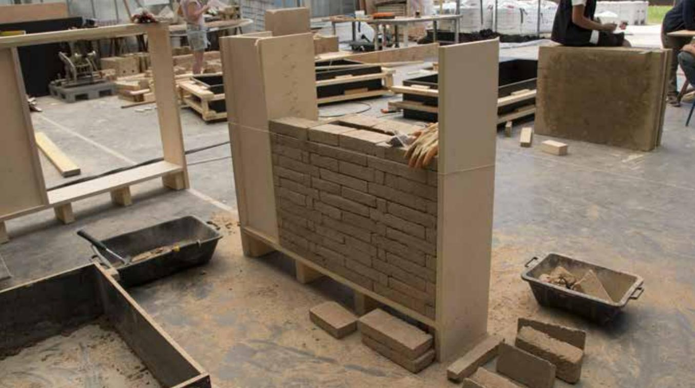
Les briques sont empilées à sec, sans mortier, avant de couler un mortier à l'intérieur.
