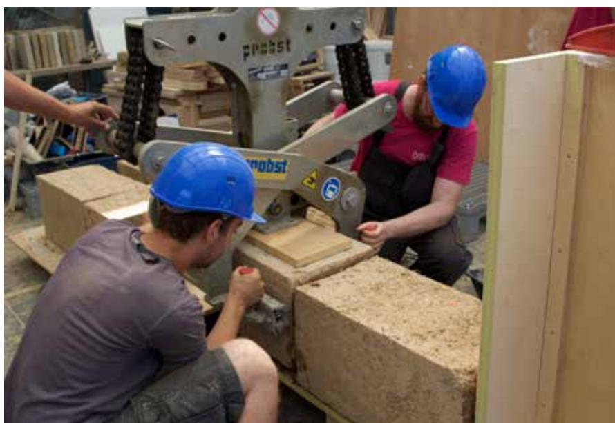
◀ Pose d'un adobón à l'aide du pont roulant.
