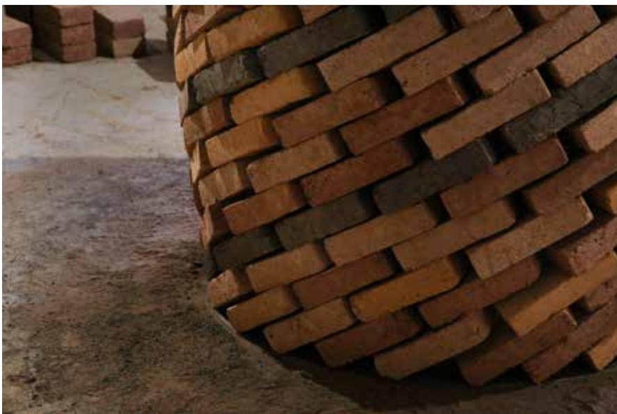
Les briques sont posées sur une arête et tiennent par friction, les unes sur les autres.
