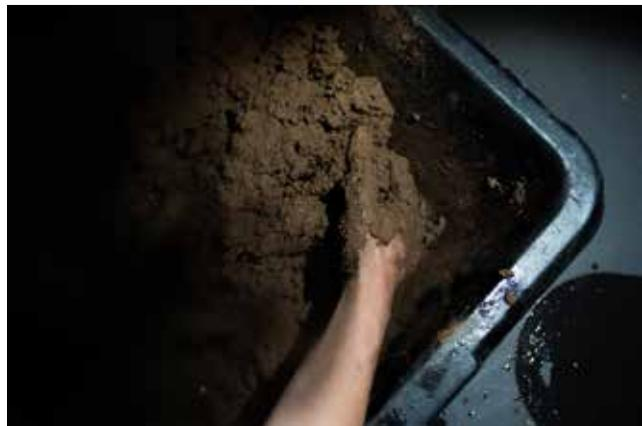
Malaxage du mélange de terre et d'eau : à la main ou à la truelle celui-ci doit permettre d'obtenir un mélange homogène et le bon état hydrique situé ici entre plastique et visqueux.
