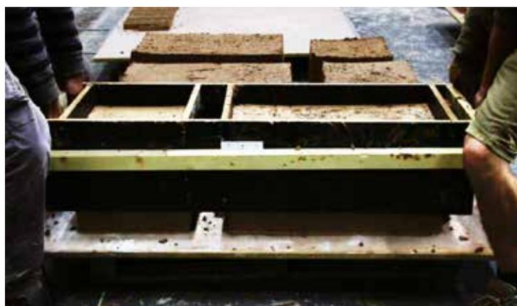
La grande taille de l'adobón nécessite d'être plusieurs pour le démouler car les forces de succion exercées sur les parois du moules sont très importantes. ▶
