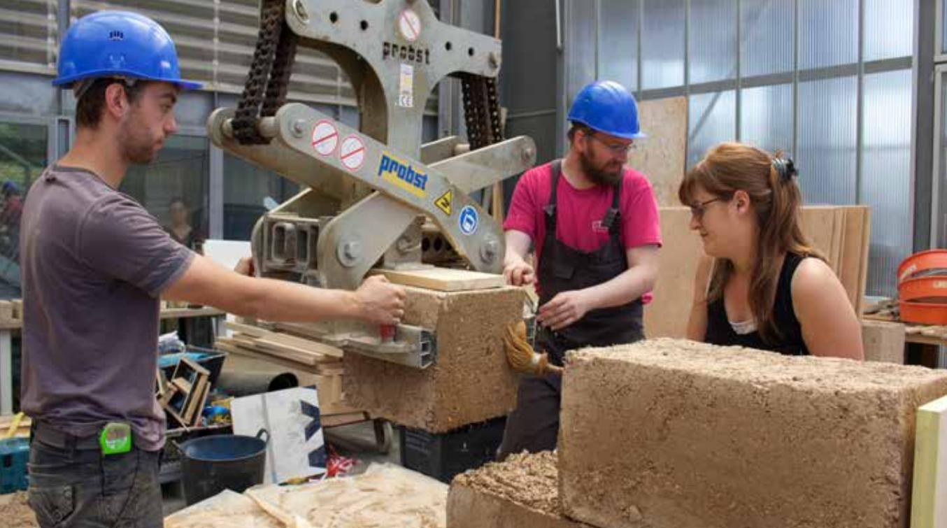
▲ Levés au pont roulant, les adobóns sont humidifiés avant d'être posés sur le mortier.
