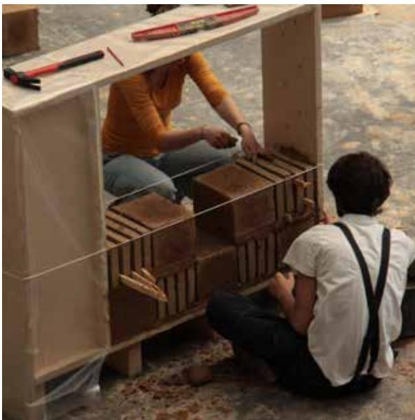
Dans ce damier d'adobes les joints verticaux sont laissés sans mortier pour permettre une ventilation. Pour cette raison, les joints horizontaux sont particulièrement épais afin de maintenir l'appareillage en libraire.
