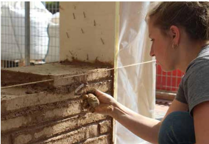
Les joints sont traités « en creux » à l'aide d'un fer à joints, soulignant ainsi l'horizontalité des briques.
