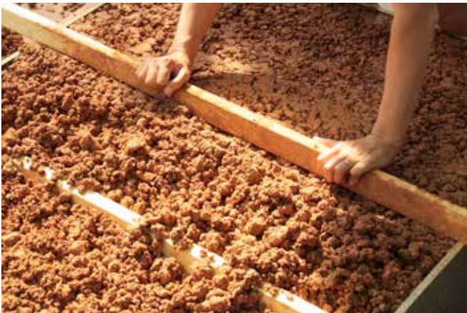
Mise en oeuvre des mélanges tirés à la règle ou simplement déversés et coulés suivant la plasticité de la composition.
