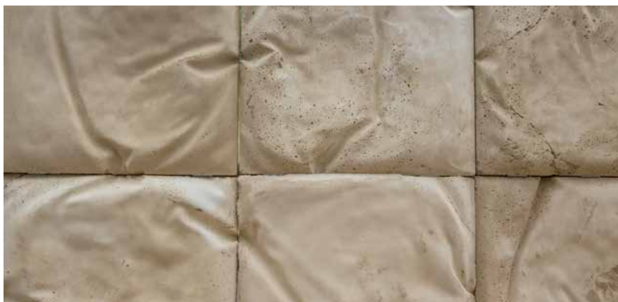
Parement de mur réalisé en terre coulée lors du festival Grains d'Isère 2016
