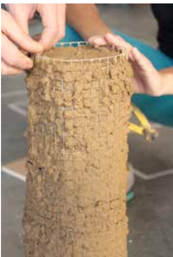
Coffrage perdu en grille
