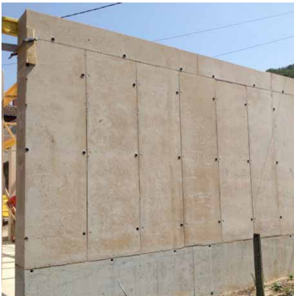
Mur en terre coulée lors de la construction d'une cuverie dans le Jura architecte M.Chevallier
