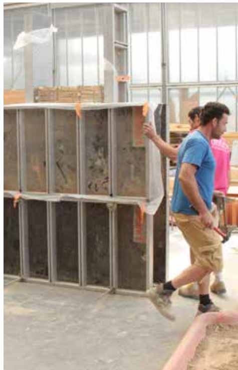
Installation des coffrages alu rigides avant coulage
