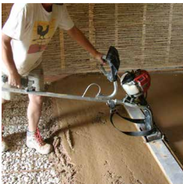
Réalisation d'une dalle en terre coulée à l'aide d'une règle vibrante
