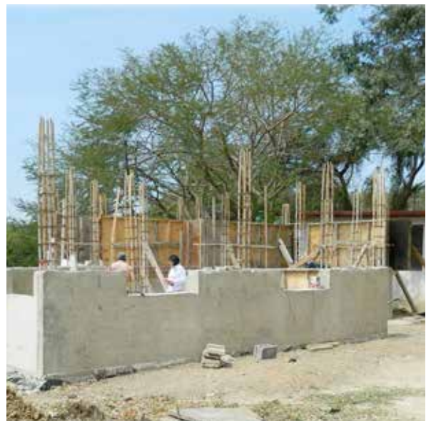
Terre renforcée en bambou mur en terre coulée armée à l'aide d'une armature en bambou, Mexique, architecture Yolanda Aranda
