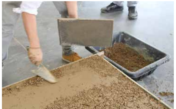
Mise en oeuvre des mélanges tirés à la règle ou simplement déversés et coulés suivant la plasticité de la composition.
