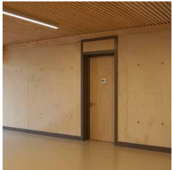
Vue intérieure sur mur en terre coulée de la maison des associations de la ville de Manom, architecture Mil-lieux
