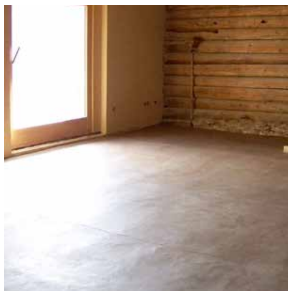
Dalle en terre coulée finition avec l'incorporation d'un chauffage au sol
