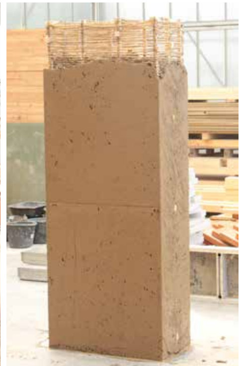
Mur en terre coulé juste après décoffrage
