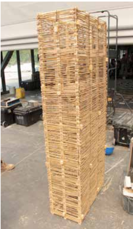
Préparation du coffrage perdu bois/canisses
