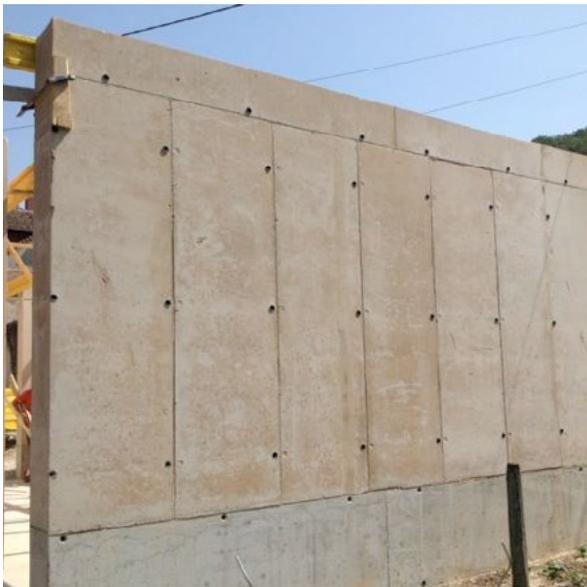
**Mur en terre coulée** lors de la construction d'une cuverie dans le Jura
