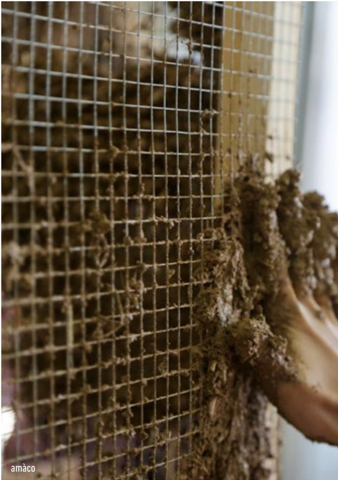
**Mot(s) clé(s) :** garnissage / torchis métallique / enduit
